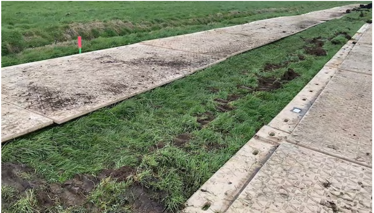
Figuur 2.14: Maaiveld na aanrijden met rupskraan te Sliedrecht 22 januari 2022 (bron: Gasunie).
