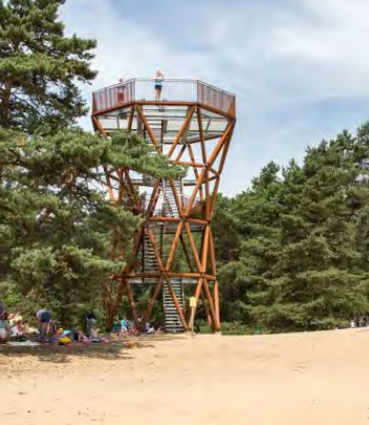
Houten uitkijktoren van zo'n 8 tot 10 meter hoog
