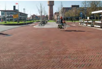
Gebakken klinker pleinen
