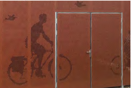
Het zichtbare deel van de fietsenstalling krijgt een cortenstalen rooster en is mogelijk afsluitbaar
