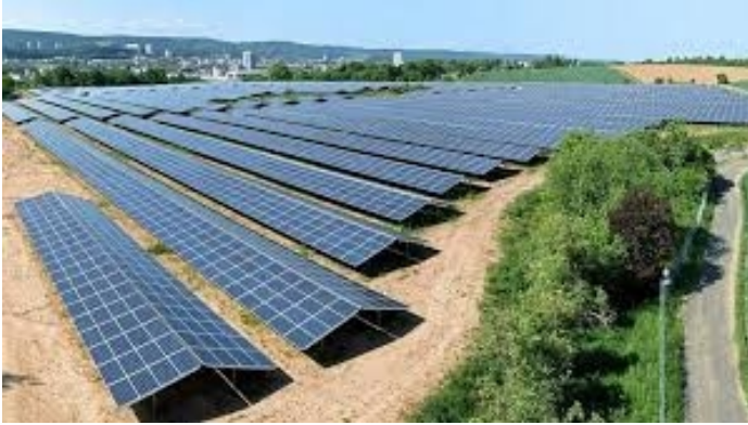
f2.2 Impressie zonnepanelen
