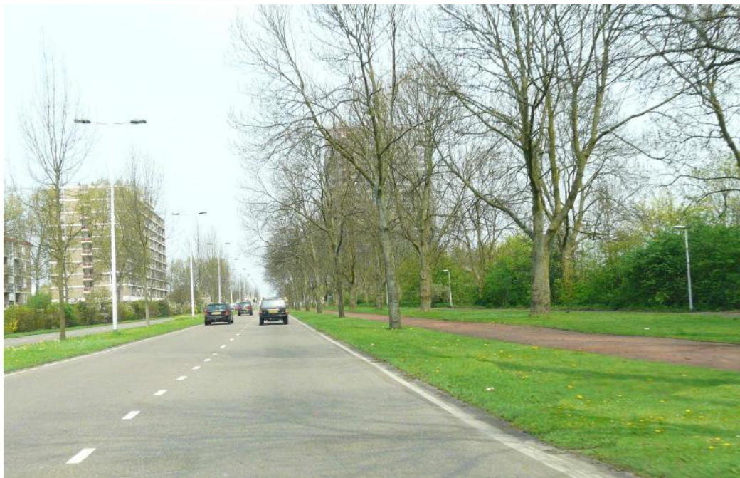
Figuur 5.1 : Foto van huidige situatie Churchillaan
