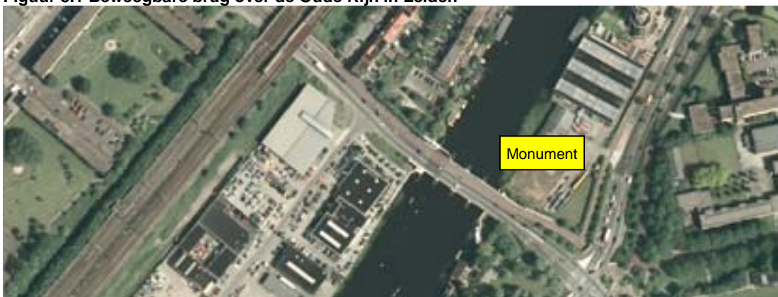
Figuur 8.1 Beweegbare brug over de Oude Rijn in Leiden
