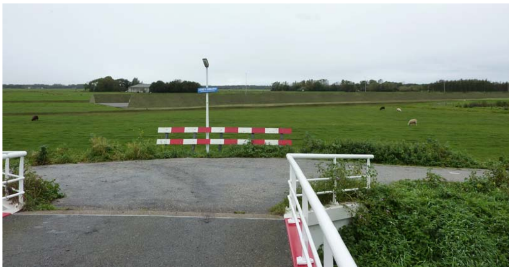
Figuur 3.30 Zicht vanaf de zuidelijke bebouwingsrand van Leiden richting het zuiden (nabij de Dobbewatering). De weg komt hier uit een tunnelbak welke onder het spoor loopt
