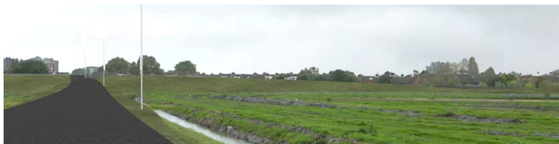
Figuur 3.26 Fotoinpassing van het zicht op de aansluiting Valkenburg I vanuit verschillende posities. Van grotere afstand is de verhoogde aansluiting nauwelijks waarneembaar. Vanaf de rand van het gebied is de aansluiting logischerwijs duidelijker zichtbaar .
