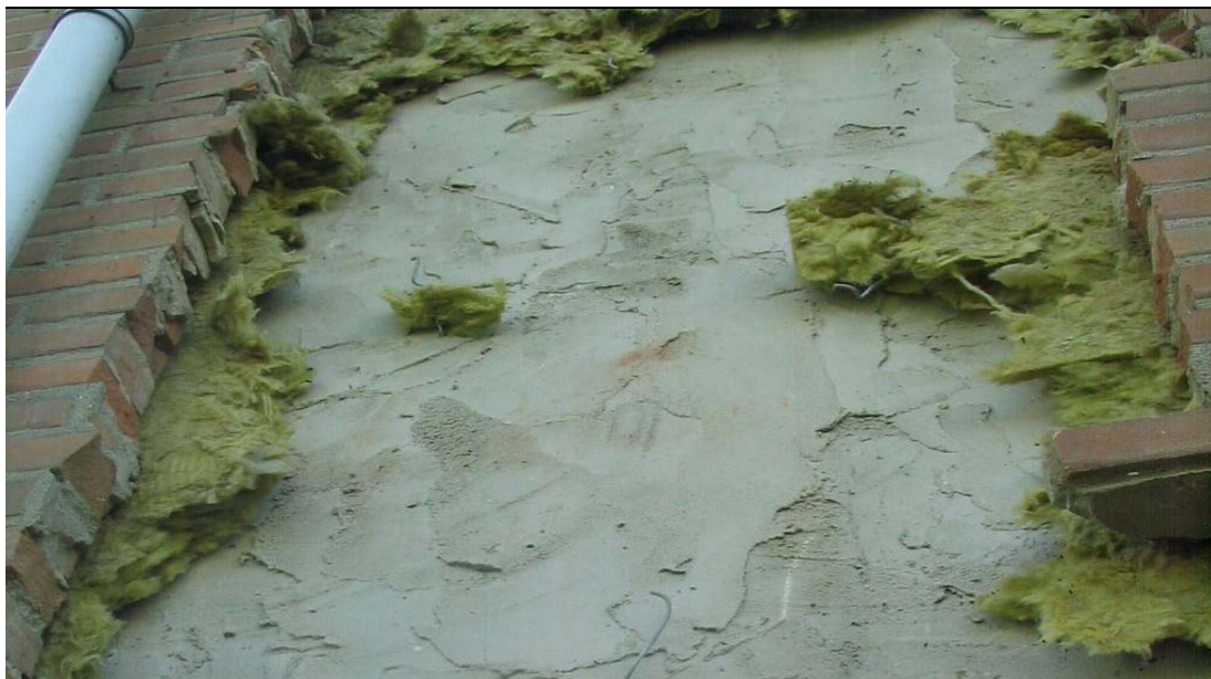
Figuur 3.18 Blootgelegde spouwmuur waar ook het isolatiemateriaal is verwijderd
