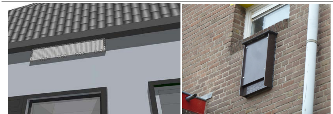
Figuur 3.23 Houten vleermuiskasten aan gevels
