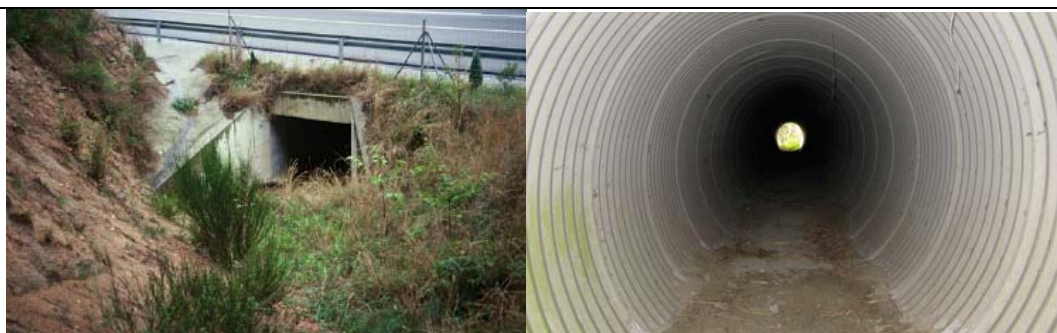
Figuur 2.3 Voorbeelden van kleine, droge faunavoorzieningen
