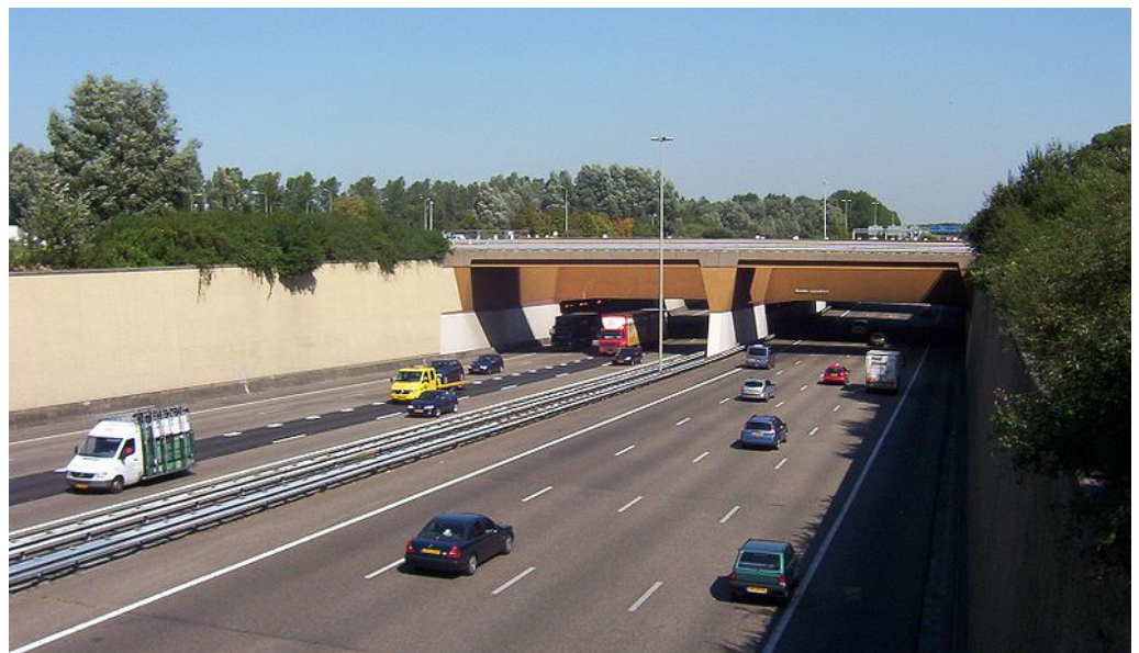
Figuur 2: Het Gouwe aquaduct
