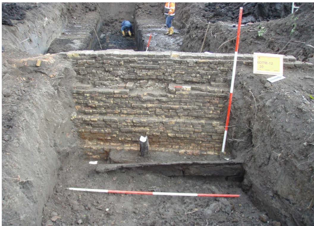
Afb. 9. Muur S33 gezien vanaf het zuiden.
