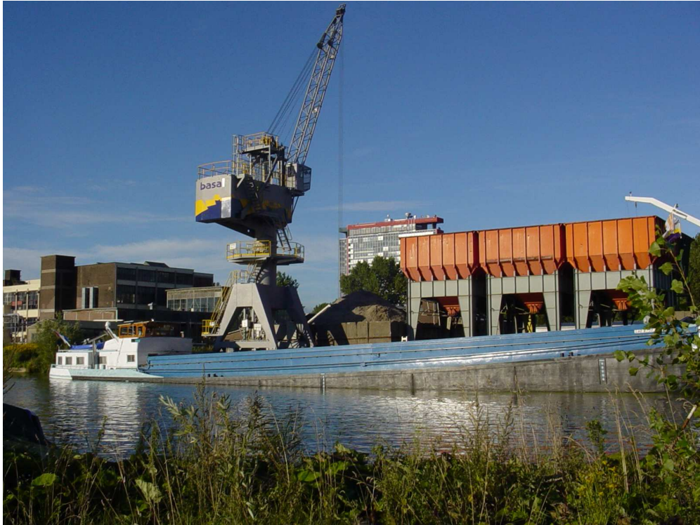
Figuur 2.3 Zand/grind overslag bij Delft
