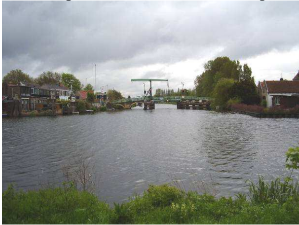
aanzicht Hoge Brug vanaf noord
