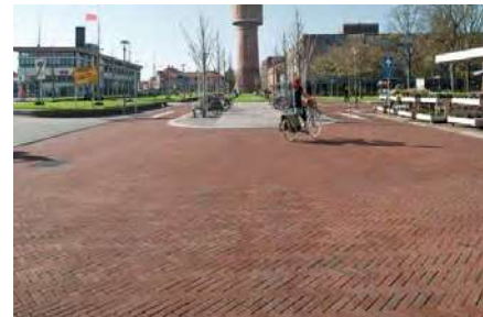
Gebakken klinker pleinen
