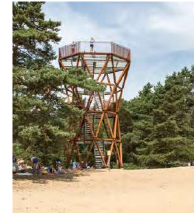
Houten uitkijktoren van zo'n 8 tot 10 meter hoog
