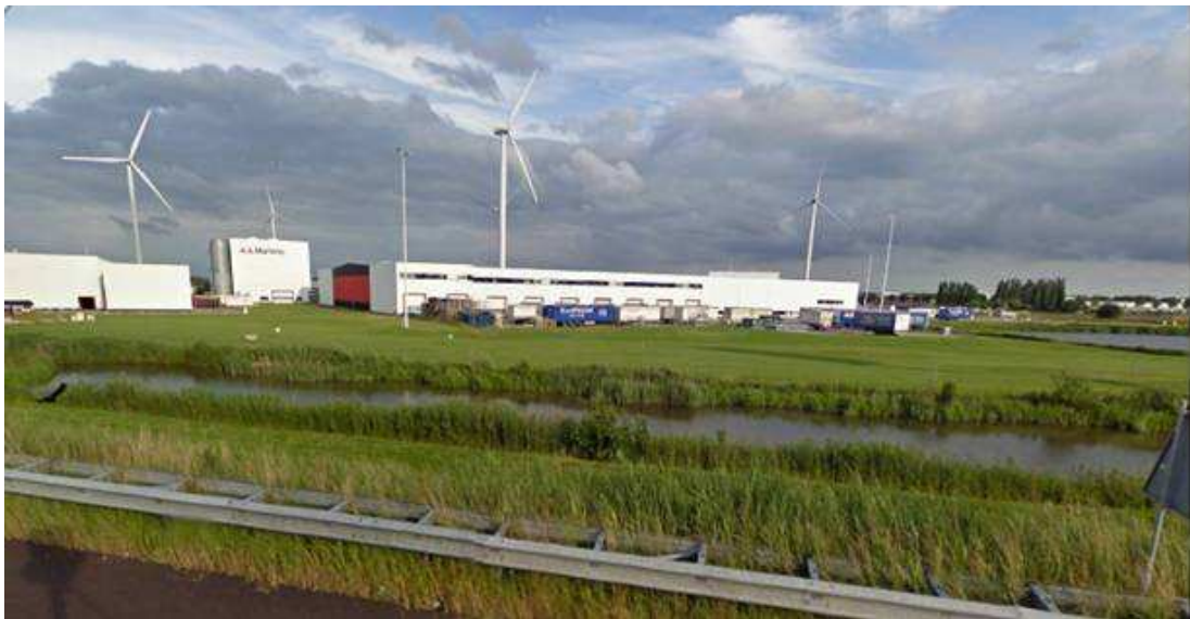
Figuur 1.2 Referentiebeeld Weststad Oosterhout. Dit betreft 6 windturbines met een ashoogte van 100 meter binnen een bedrijventerrein met bouwhoogten tot 30 meter
